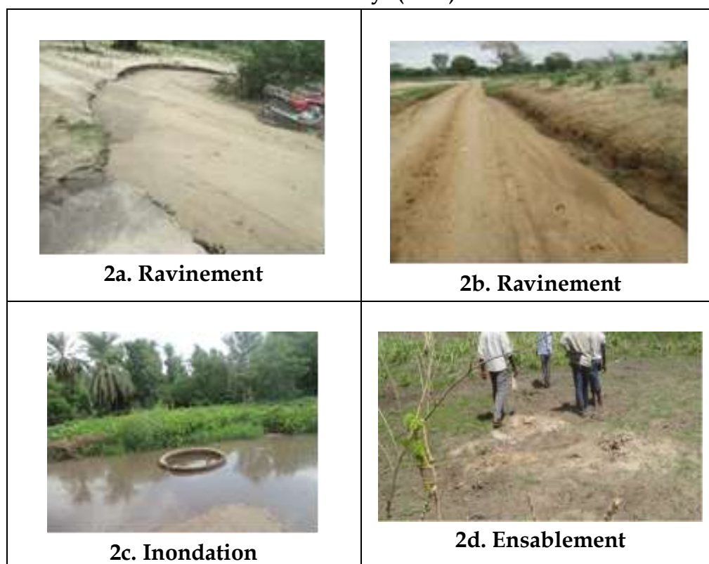
Planche 2 : Conséquences de la hausse des ruissellements dans le bassin de la cuvette de Gayi (2016).
