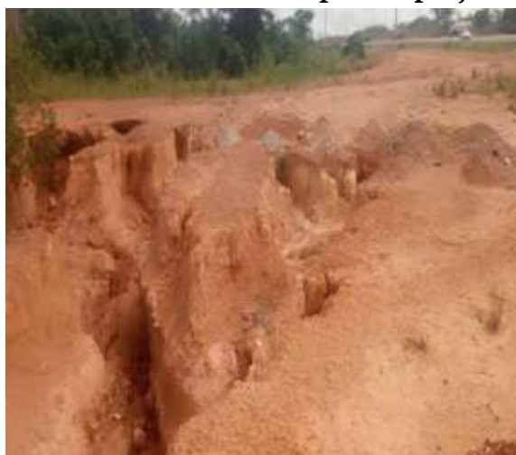
Photo 3 : État du sol après le projet
