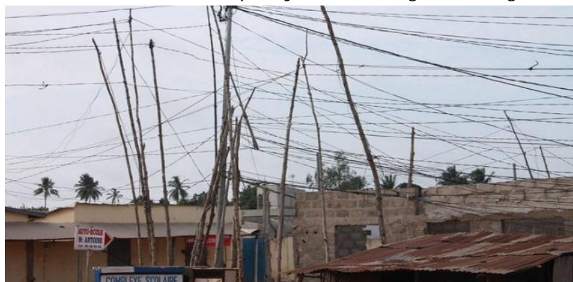
Photo 1 : Branchement par système d'araignée à Sanguéra
