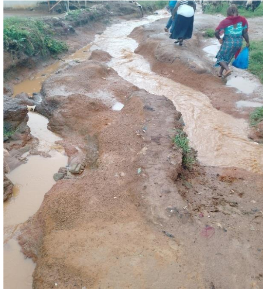
Photo 6. Erosion des berges du cours d'eau
