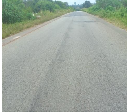
Photo 2 : Vue d'une voie A
