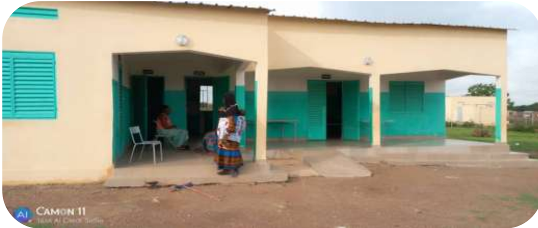
Photo 1: Le CSCOM de Bougoudalé construit par la SMK
