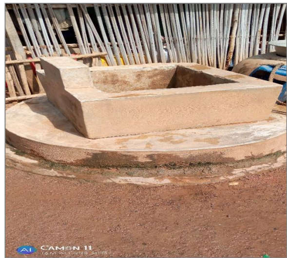
2b: Puits à ciel ouvert au quartier Commerce
