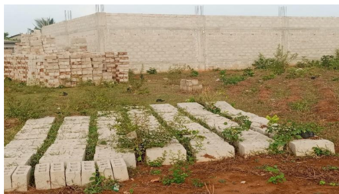
Photo 1 : Domaine en chantier à Vakon-Gbo
