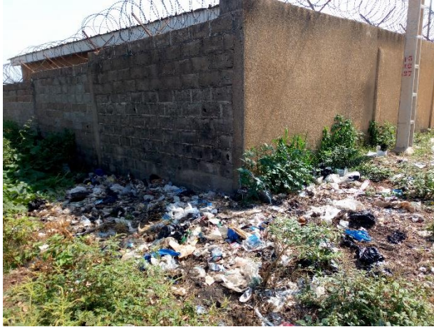
Photo 1 : Présence d'ordures ménagères à proximité d'une habitation
