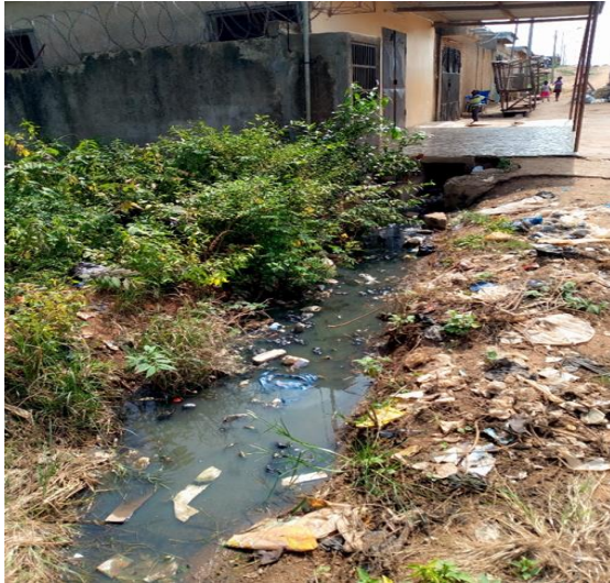
Photo 3 : Stagnation des eaux usées domestiques à proximité d'une habitation
