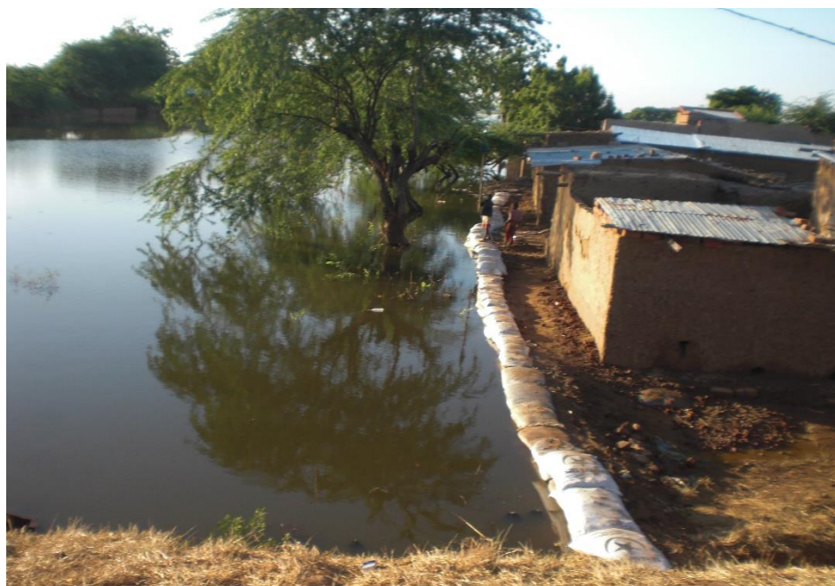
Photo 2. Construction locale des diguettes défailantes
