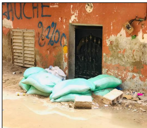
Photo 8: Digue de protection avec des sacs de sable à Darou Missette. Source : M. Ndiaye, août 2025
