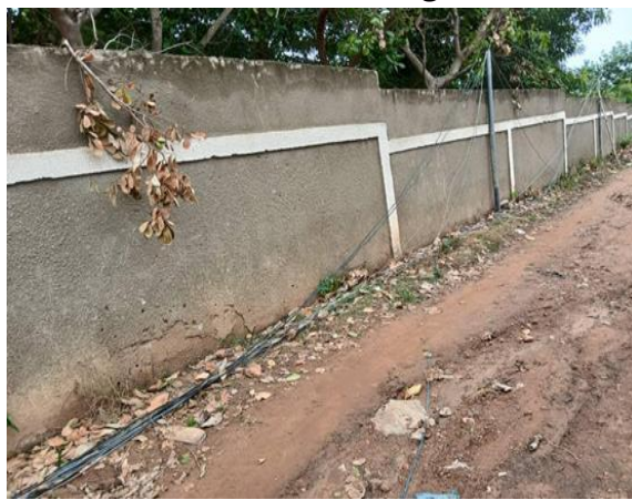
Photo 3 : Branchement illégal au réseau public d'électricité au quartier Extension sud de Zoukougbeu
