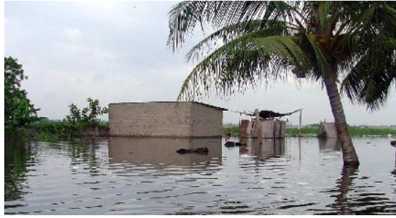
Photo n°3b : Vue externe d'une maison inondée à Kanykopé
