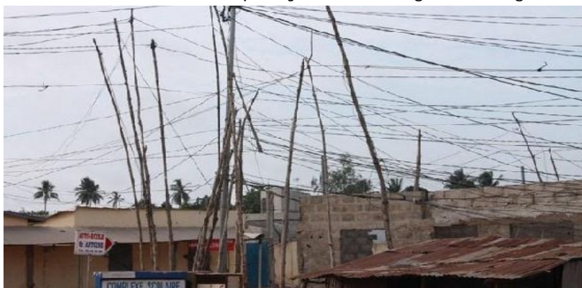
Photo 1 : Branchement par système d'araignée à Sanguéra
