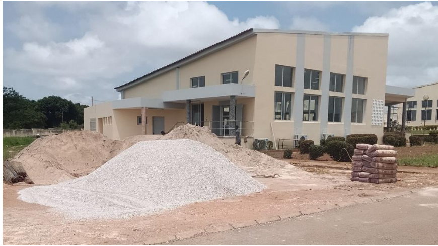
Photo 1 : Observation des travaux de réhabilitation de l'UAO
