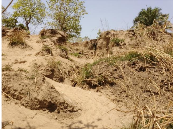
Photo 4a. Ouverture des lignes d'érosion par marche
