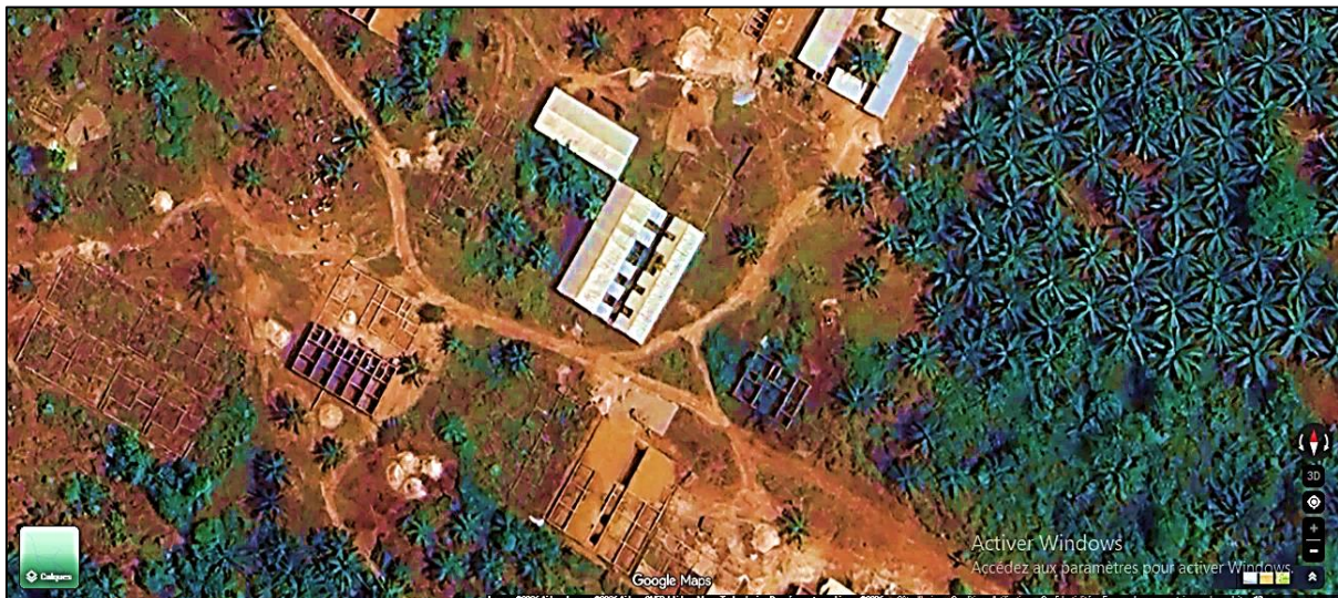
Photo 1 : Un lotissement privé au quartier Dialogue 2-Extension en voie de construction
