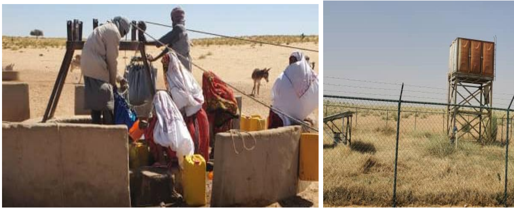
Photo 2: un puits cimenté de Sabagdach à gauche et un mini AEP de N'Djaména à droite.
