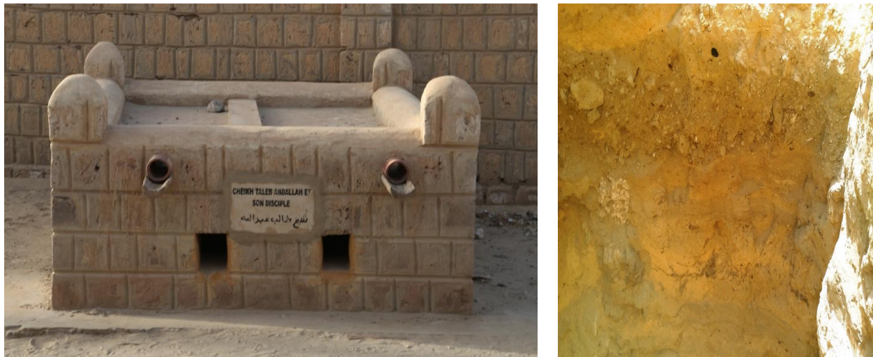
Photo n°4 : A gauche, mausolée Cheikh Taleb Abdallah revêtu d' alhor à l'extérieur et les enduits intérieurs faits avec la terre de Bourem en couleur ocre, sont bien visibles à droite.
