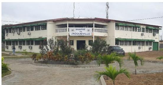
Photo 1 : La mairie réhabilitée
