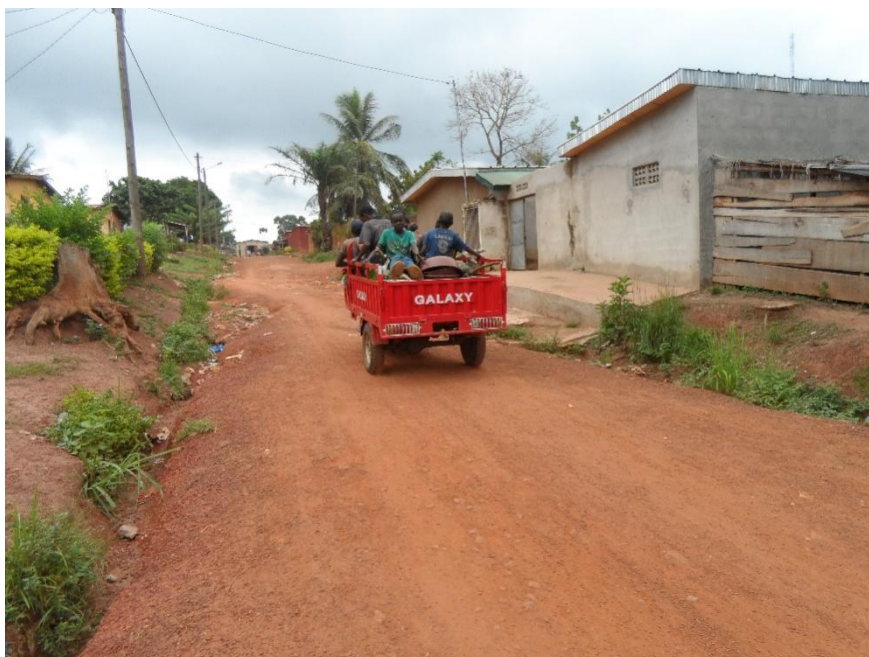
Photo 2 : la voirie de la ville de Zoukougbeu
