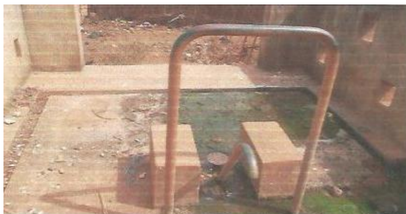
Photo 3: Vue partielle d'un Forage de Pompe à Motricité Humaine à Dékandji
