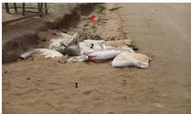
Photo 11 : Dispositif antiérosif mis en œuvre par des riverains dans une rigole
