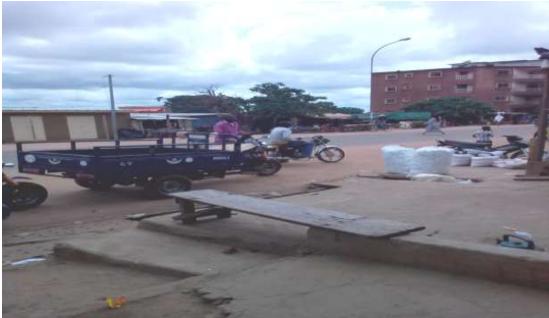
Photo 4 : Des activités de commerce installées sur un caniveau bouché obstruant le passage de l'eau en bordure d'une route bitumée à Bouaké
