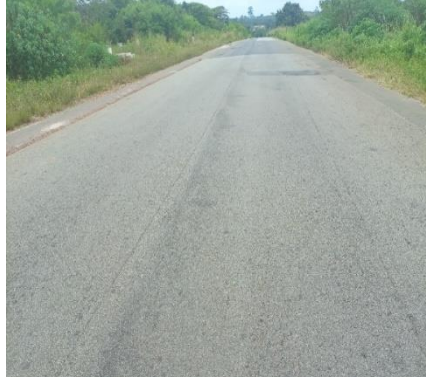
Photo 2 : Vue d'une voie A
