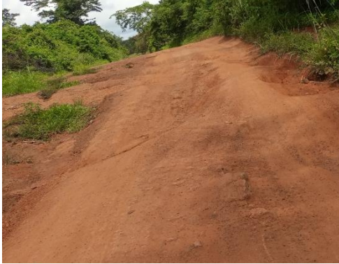
Photo 1 : Vue d'une voie B
