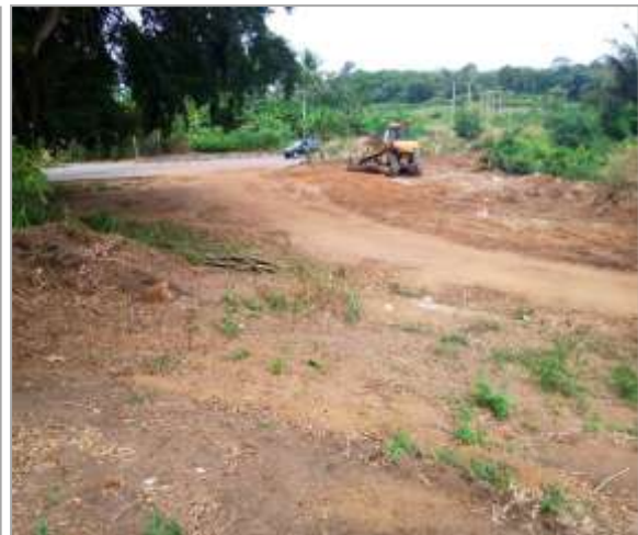
Photo 2 : Un lotissement en cours de réalisation en bordure de la voie Abidjan-Dabou
